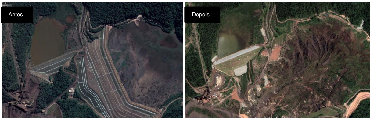
Imagem 1 – Área da Barragem I da Mina do Córrego Feijão, antes e depois do rompimento
