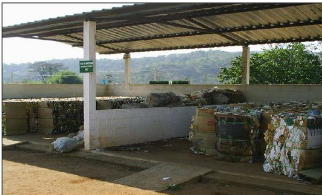
Figura 11.9 – Unidade de triagem e compostagem – Processamento de recicláveis.
