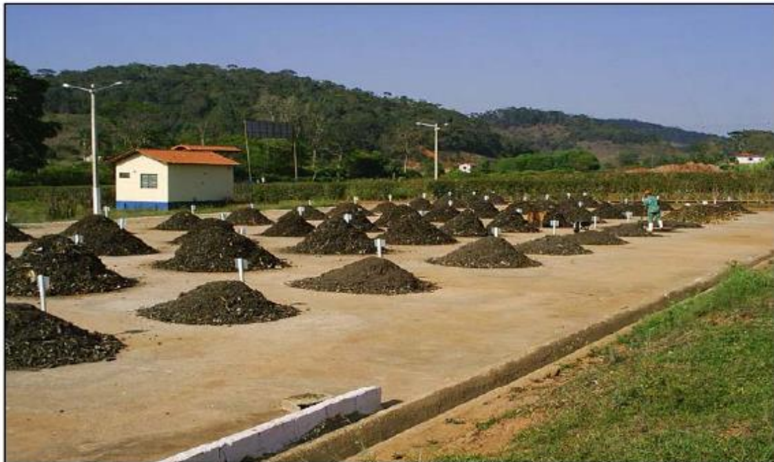
Figura 11.8 – Unidade de triagem e compostagem – Compostagem de orgânicos.
