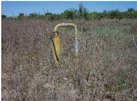
Figura 9.32. Poço do Sítio Rocinha.
