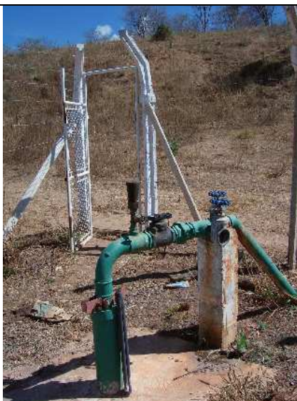
Figura 9.2. Poço IVD30. Poço comunitário
