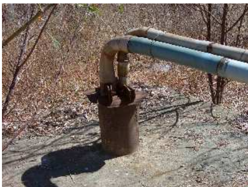
Figura 9.81. Poço IVZ 5 e 6.
