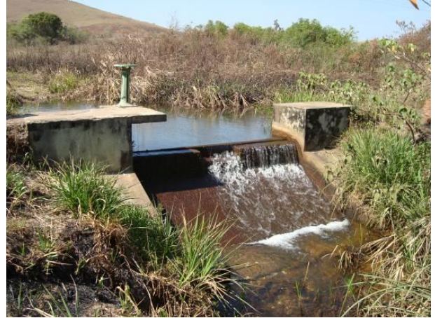
Figura 66 - Captação para abastecimento doméstico e industrial da sede municipal de Carandaí.
