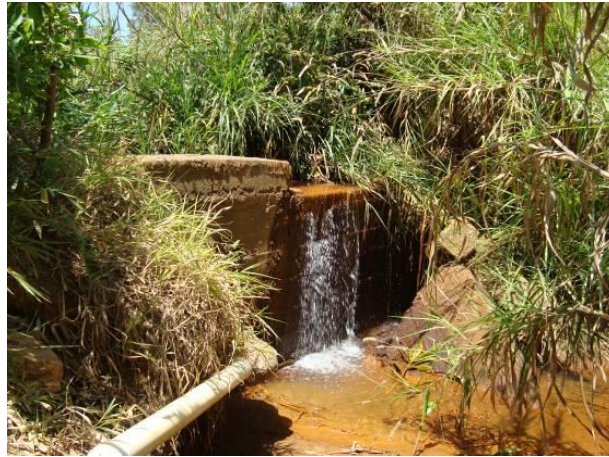
Figura 127 - Ponto de captação para o abastecimento doméstico da localidade rural denominada Januário (São João Del Rei).
