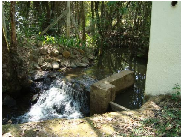
Figura 67 - Ponto da captação para abastecimento doméstico do distrito de Pedra do Sino (Carandaí).
