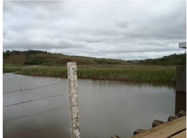
Figura 189 - Ponto de captação para o abastecimento doméstico e industrial da sede municipal de Oliveira.
