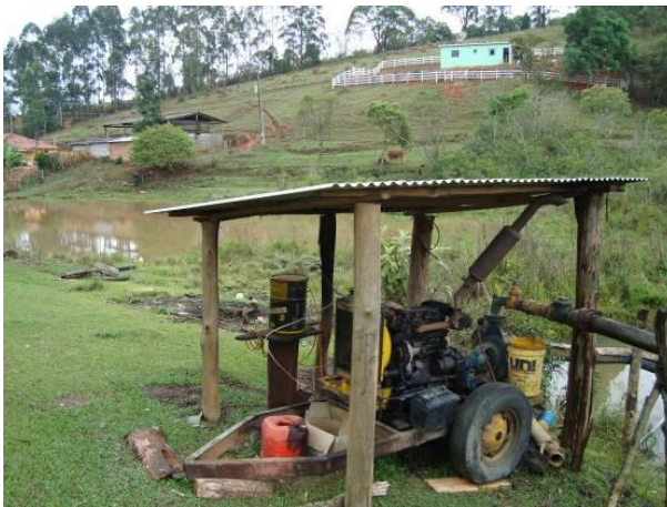
Figura 70 – Captação para a irrigação de olerícolas.
