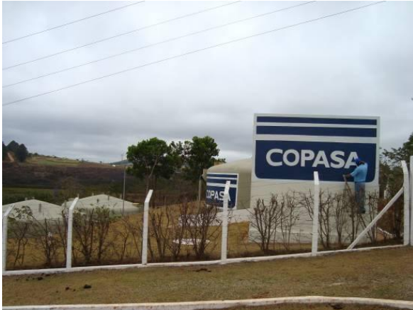
Figura 132 - Estação de tratamento de esgoto da sede municipal de São Tiago.
