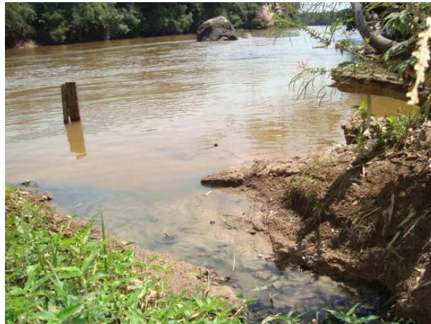
Figura 138 - Lançamento de efluentes domésticos da sede municipal de Ibituruna, bairros São Sebastião e Estação.
