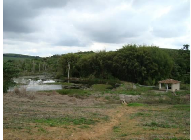
Figura 172 - Captação para a irrigação por aspersão tipo pivô-central.
