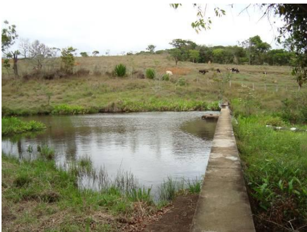
Figura 186 - Ponto de captação para o abastecimento doméstico e industrial da sede municipal de Oliveira.
