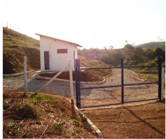
Figura 44 - Estação de tratamento de esgoto de Ressaquinha.
