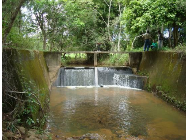
Figura 144 - Captação para o abastecimento doméstico e industrial da sede municipal de Bom Sucesso.
