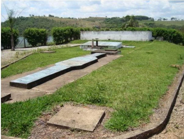
Figura 154 - Estação de tratamento de esgoto do povoado rural Ponte do Funil (Lavras).
