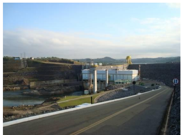
Figura 159 - Usina Hidrelétrica Funil.
