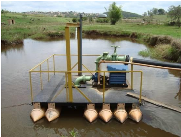
Figura 211 - Em destaque a balsa de captação para o abastecimento doméstico e industrial da sede municipal de Cana Verde.
