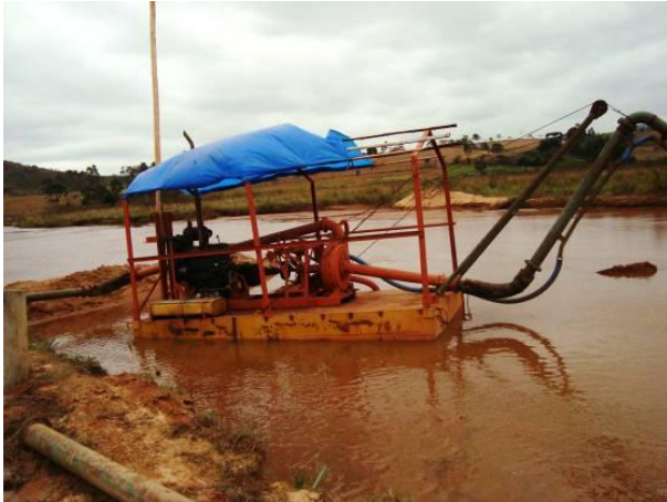
Figura 182 – Dragagem/extração de areia sendo executada no rio Jacaré.
