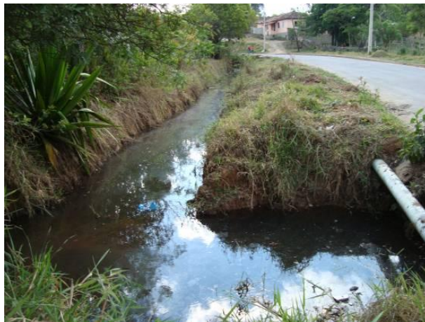
Figura 119 - Ponto de lançamento de efluentes domésticos e industriais provenientes da sede municipal de Ritápolis.
