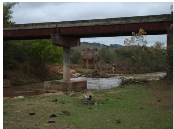
Figura 135 - Futuro ponto de captação para o abastecimento doméstico e industrial da sede municipal de São Tiago.
