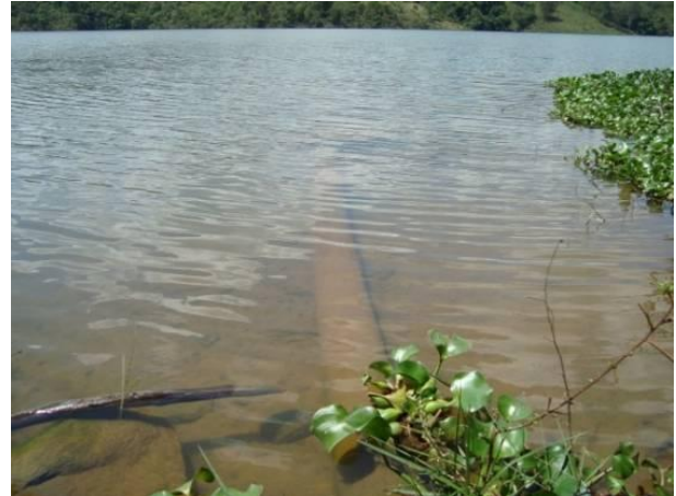
Figura 155 - Ponto de lançamento de esgoto tratado do povoado rural Ponte do Funil (Lavras).
