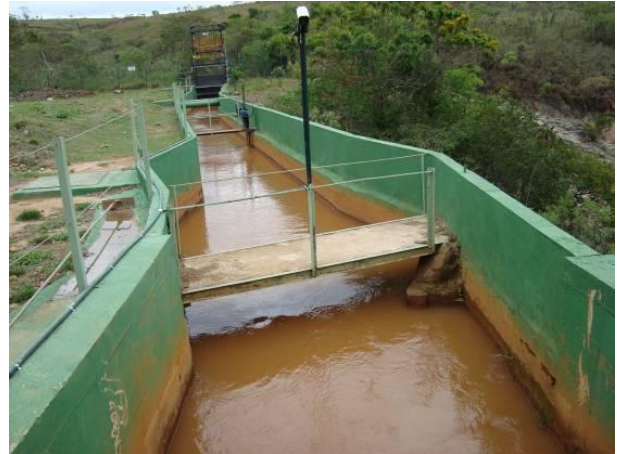
Figura 183 - Ponto de captação para a geração de energia "PCH Luz Boa".
