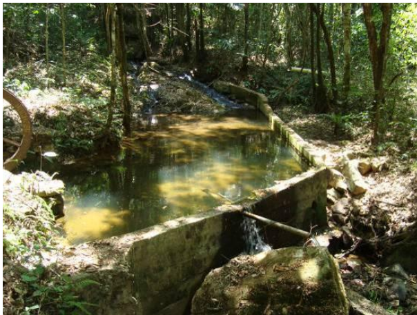
Figura 55 - Ponto de captação para o abastecimento doméstico e industrial da localidade rural de Bichinho (Prados).
