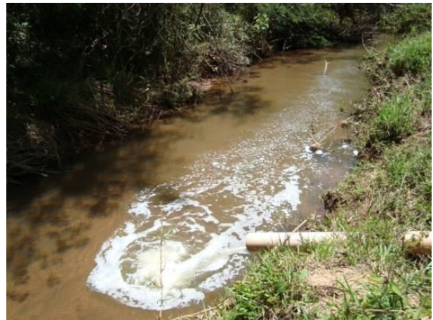
Figura 202 - Ponto de lançamento de efluentes tratados.
