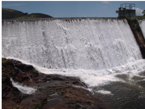
Figura 123 – Usina dos Moinhos, localizada no ribeirão Barba de Lobo.
