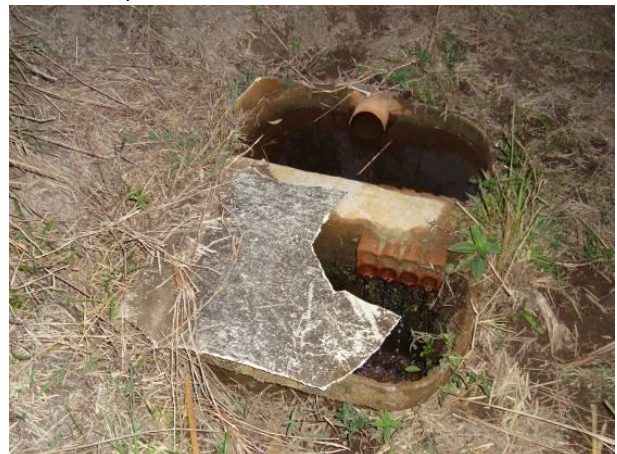
Figura 185 - Ponto de captação para o abastecimento doméstico e industrial do povoado rural Içara (São Tiago), localizado no córrego Sipião.
