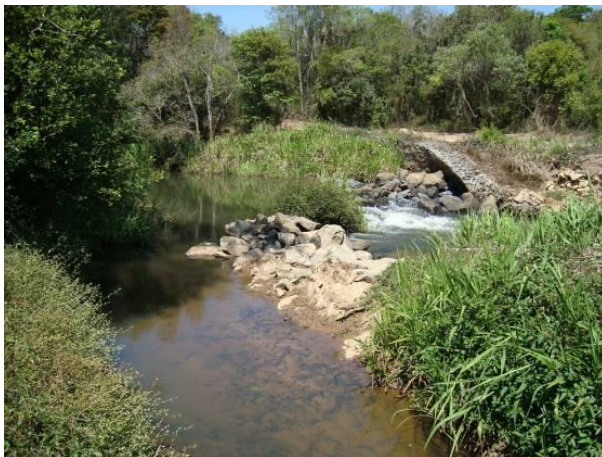
Figura 4 - Ponto de captação para abastecimento doméstico e industrial da sede municipal da Barbacena.
