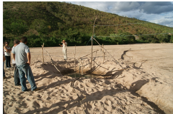
Figura 7.3 - Captação rudimentar no aluvião do rio Itinga
