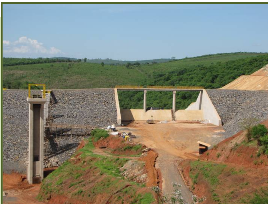
Figura 2 – Barragem do Setúbal, em Jenipapo de Minas. Fonte: Agência Minas, janeiro de 2010.
