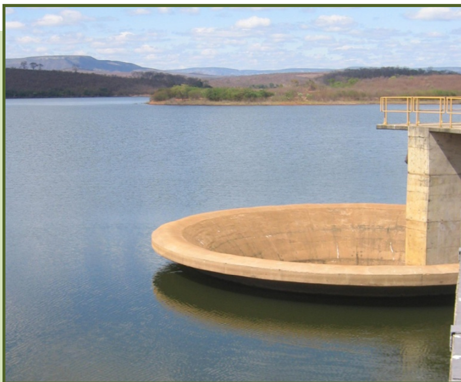
Figura 1 – Barragem do Calhauzinho, em Araçuaí.
