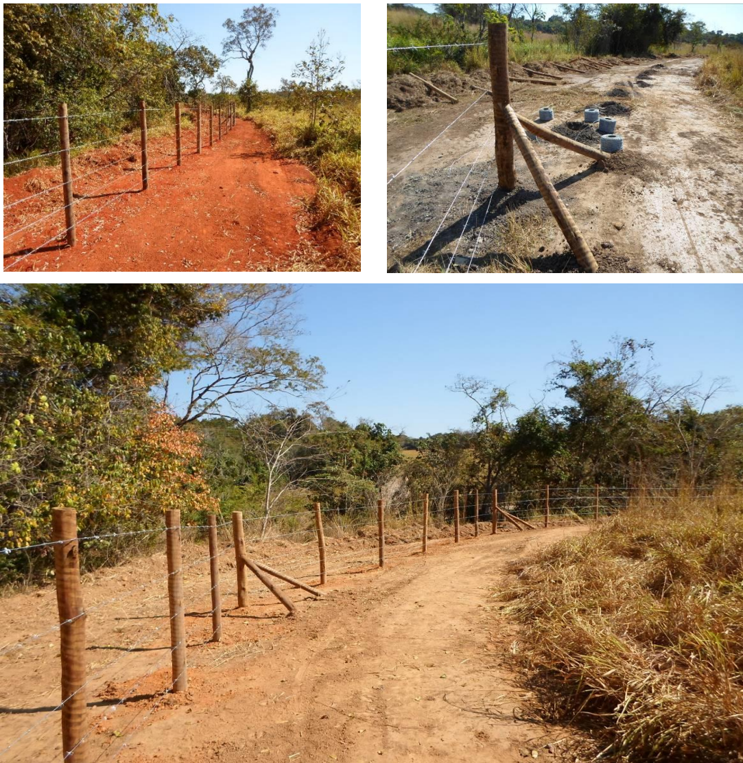
Figura 16.7 – Cercas construídas no projeto de recuperação hidroambiental da bacia do Entorno da Represa de Três Marias em Morada Nova de Minas/MG.
