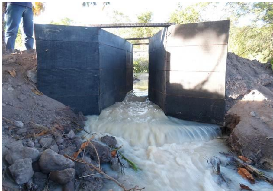
Figura 3.5 – Seção com Calha Parshall.
