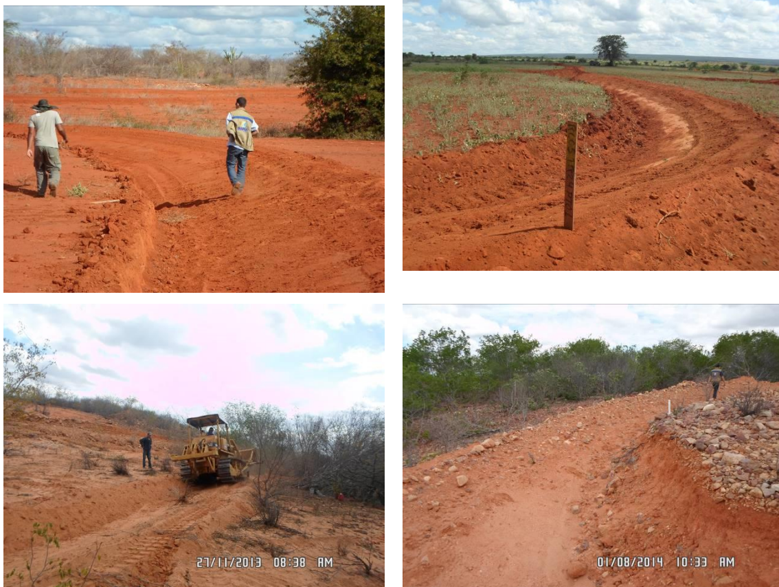
Figura 13.8 – Terraços construídos em projetos hidroambientais da bacia do rio São Francisco.
