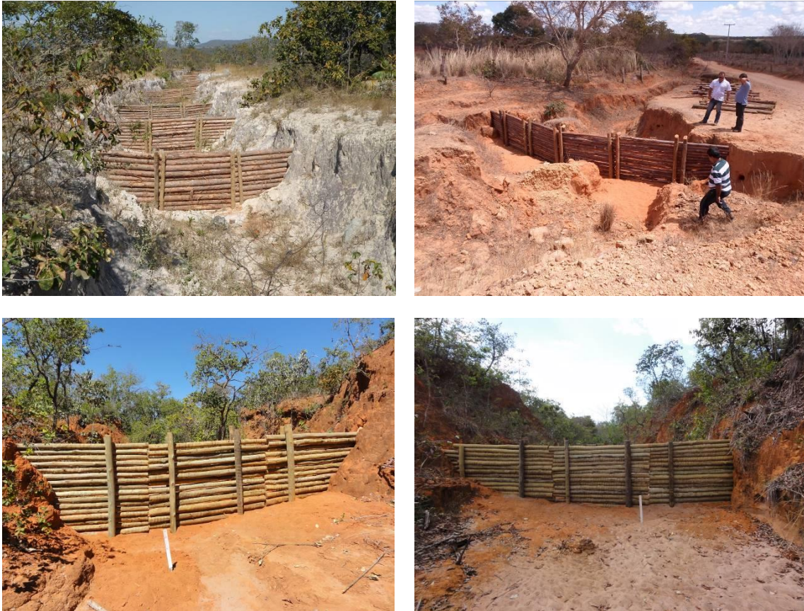
Figura 13.12 – Paliçadas construídas em projetos hidroambientais da bacia do rio São Francisco.
