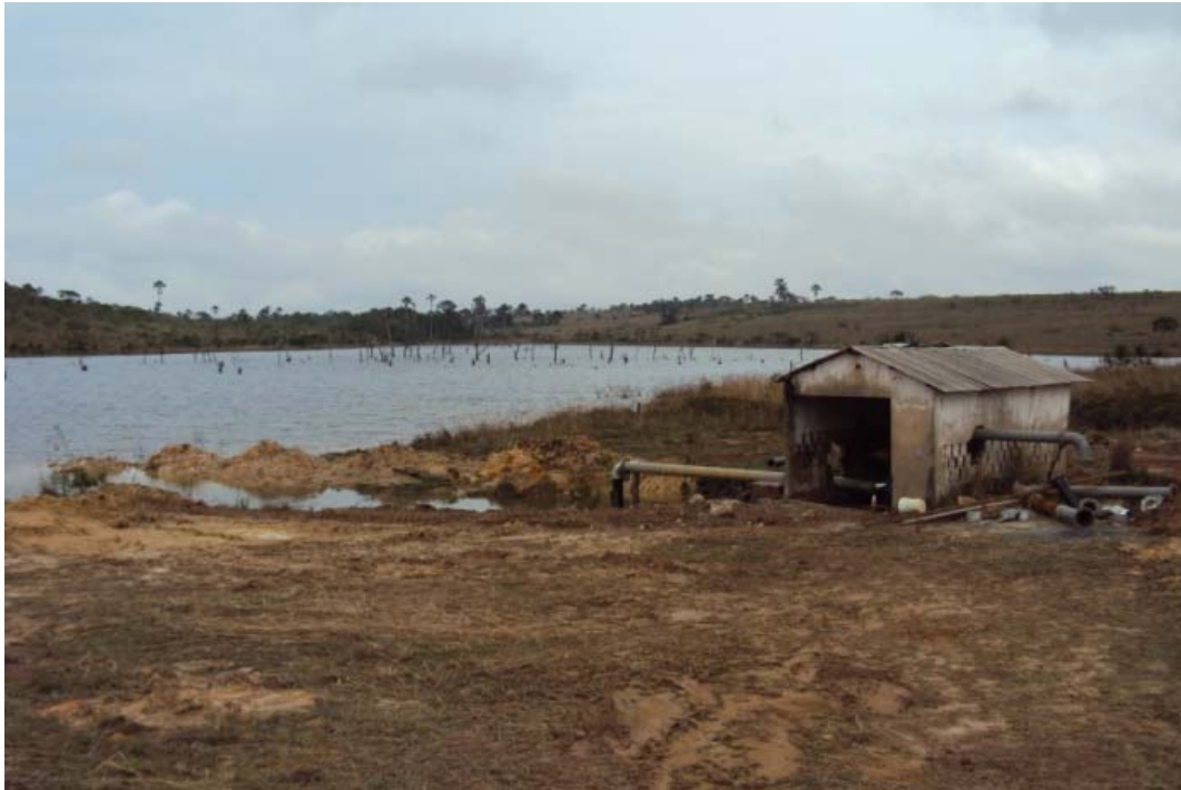
Figura 14.20 - Captação para uso de irrigação com pivô central, no rio Ponte Grande em Formoso. Fonte: Consórcio Ecoplan-Lume-Skill, 2011.
