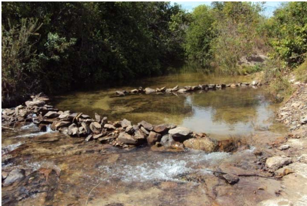
Figura 14.74 - Captação para irrigação no riacho das Tabocas. Fonte: Consórcio Ecoplan-Lume-Skill, 2011.
