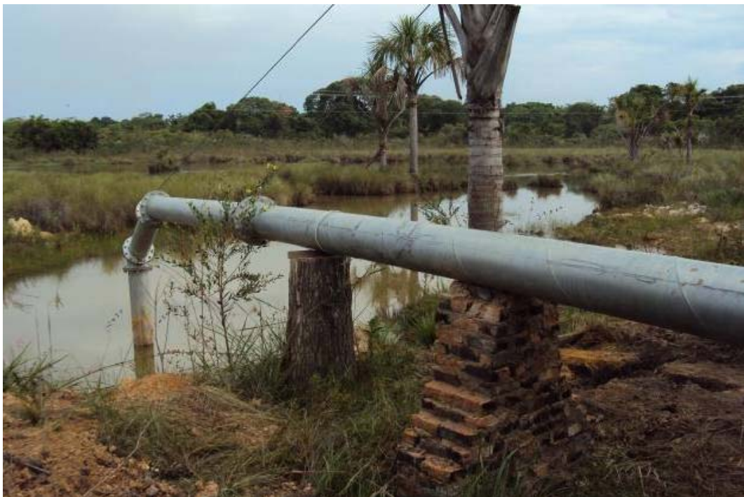
Figura 14.37 - Captação para irrigação as margens do lago em meio a sede urbana de Formoso. Fonte: Consórcio Ecoplan-Lume-Skill, 2011.
