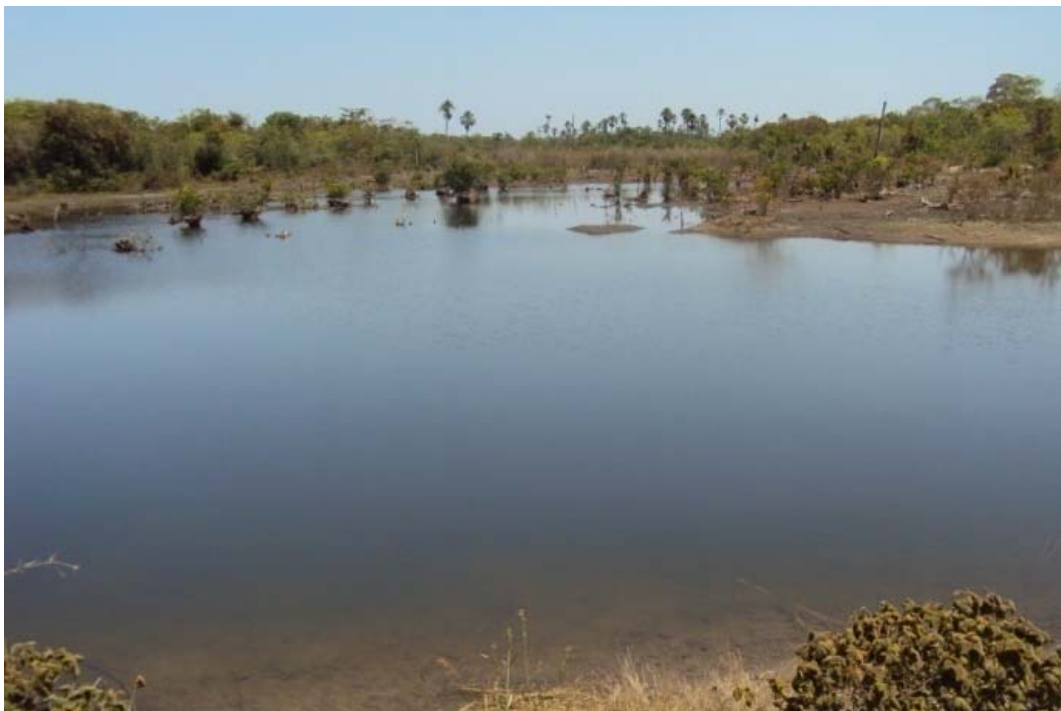
Figura 14.113 - Terceira barragem localizada também mais ao final do trecho, no riacho da Ponte. Fonte: Consórcio Ecoplan-Lume-Skill, 2011.
