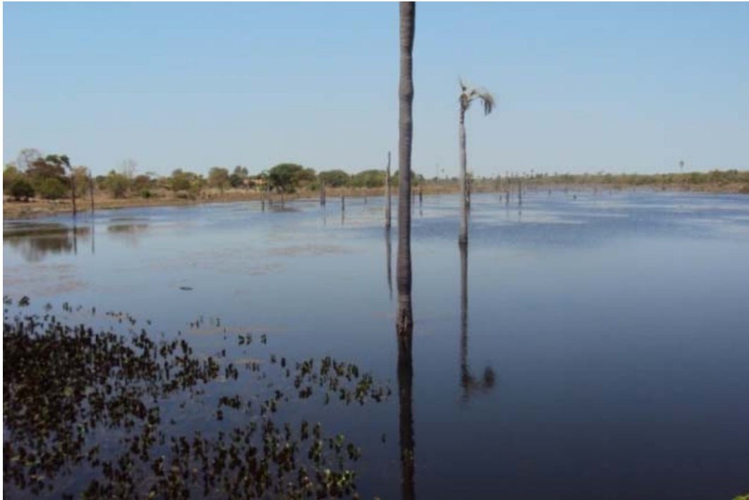
Figura 14.112 - Segunda barragem localizada mais ao final do trecho, no riacho da Ponte. Fonte: Consórcio Ecoplan-Lume-Skill, 2011
