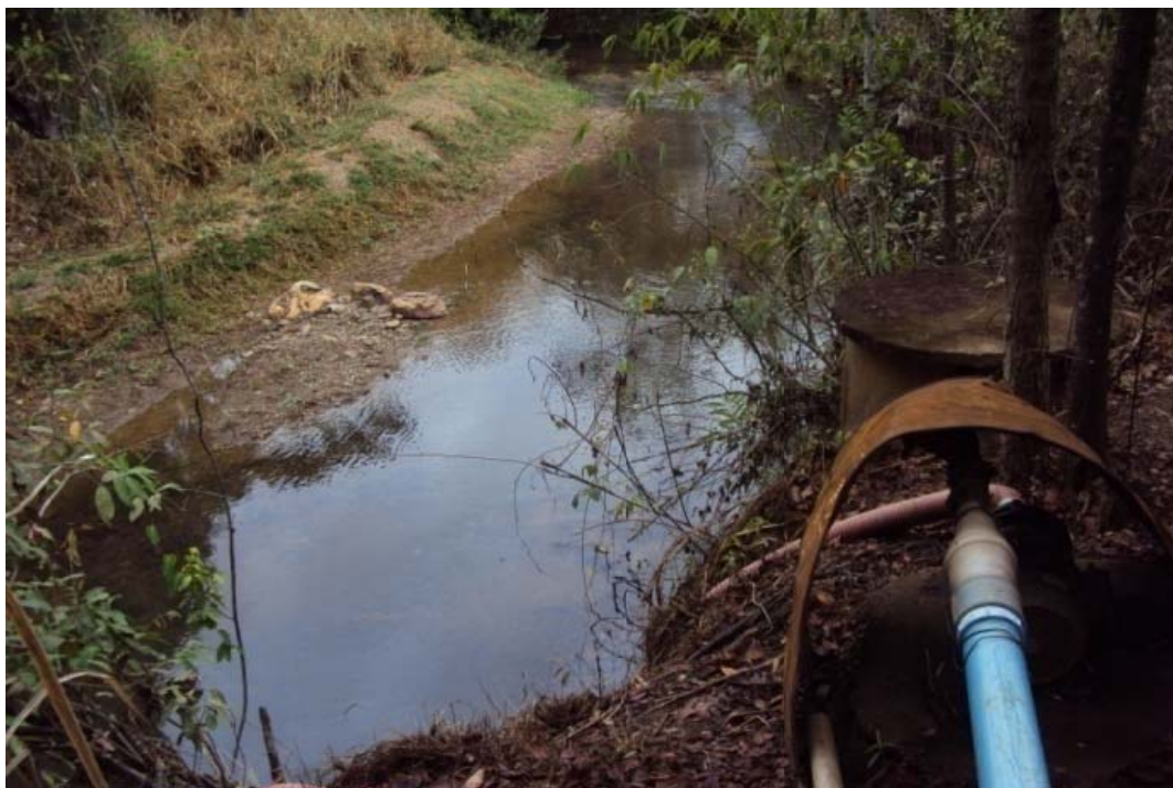
Figura 14.56 - Captação da sede de Uruana de Minas no ribeirão Suçuarana. Detalhe para a margem direita com a vegetação suprimida. Fonte: Consórcio Ecoplan-Lume-Skill, 2011.
