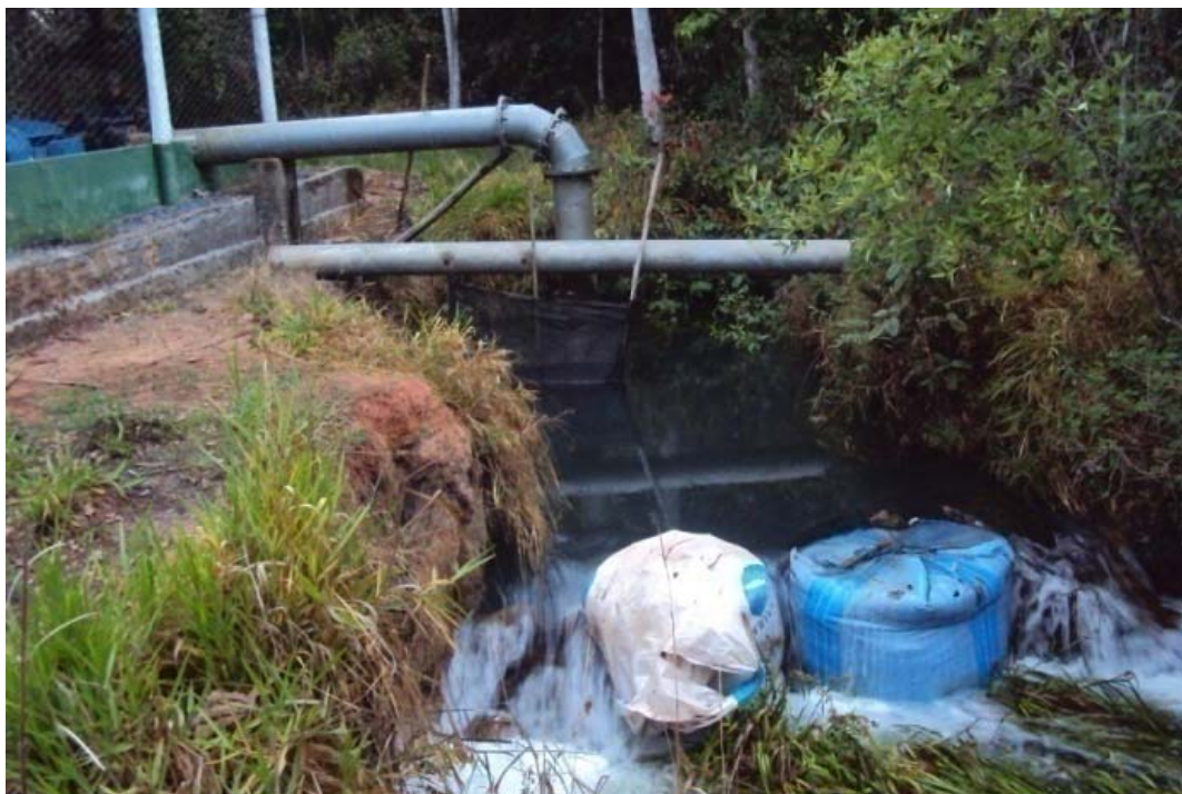
Figura 14.89 - Captação superficial no ribeirão Santo André para irrigação com sistema de pivô central. Fonte: Consórcio Ecoplan-Lume-Skill, 2011.
