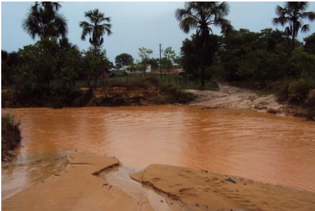
Figura 14.66 - Assoreamento das margens do ribeirão, devido ao carreamento de material de montante. Fonte: Consórcio Ecoplan-Lume-Skill, 2011.
