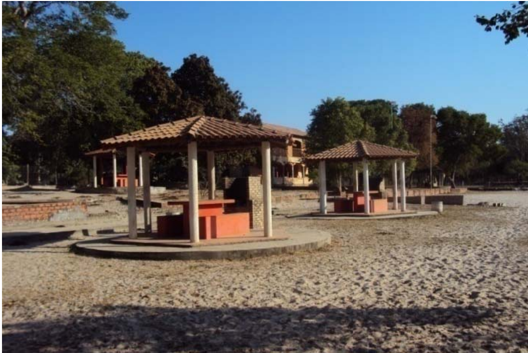
Figura 14.116 - Estruturas do balneário Riacho da Ponte, em São Romão. Fonte: Consórcio EcoPLAN-Lume-Skill, 2011.
