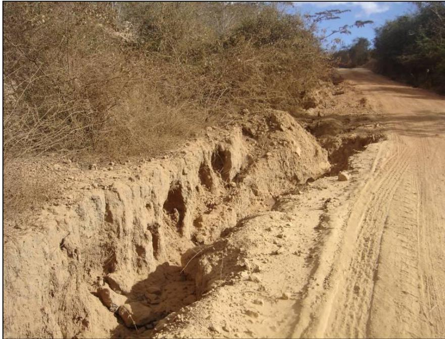
**Figura 3.40 – Erosão por sulco nas laterais das estradas por deficiência de sistemas de drenagem**
