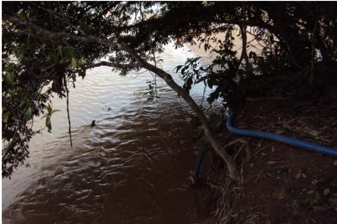
Figura 14.26 -Captação da localidade Prata no córrego Santa Catarina, no município de Chapada Gaúcha. Fonte: Ecoplan-Lume-Skill, 2011.
