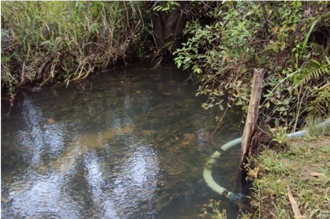
Figura 14.39 -Captação para o distrito de Várzea Bonita, distribuída sem tratamento. Fonte: Ecoplan-Lume-Skill, 2011.
