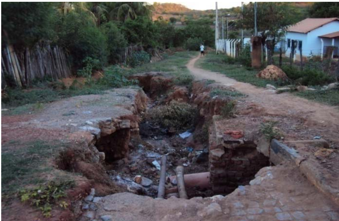
Figura 14.100 - Erosão formada na rua Alagoas no distrito de São Sebastião dos Poções, onde o material carrega para o riacho dos Poções. Fonte: Ecoplan-Lume-Skill, 2011.
