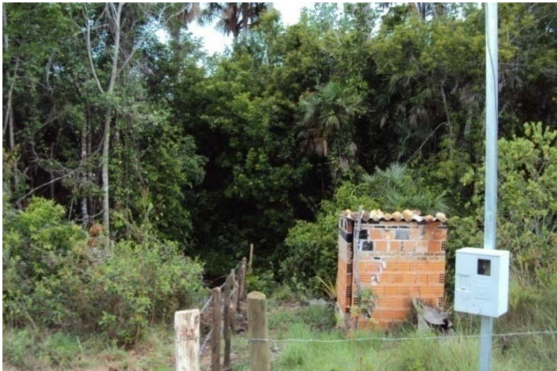
Figura 14.18 -Captação na vereda Quati para abastecimento da localidade Quati I em Chapada Gaúcha. Fonte: Ecoplan-Lume-Skill, 2011
