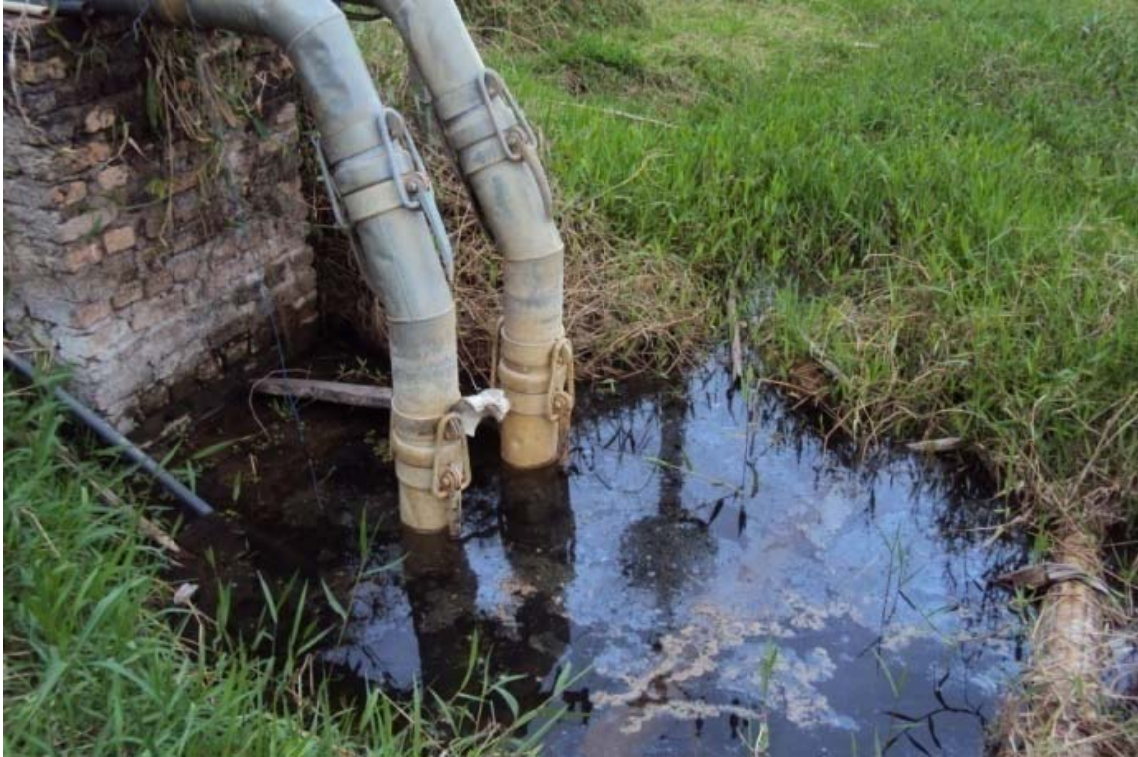
Figura 14.58 -Captação às margens do riacho dos Cochos para irrigação de culturas arbóreas (mamão) em Januária. Fonte: Ecoplan-Lume-Skill, 2011.
