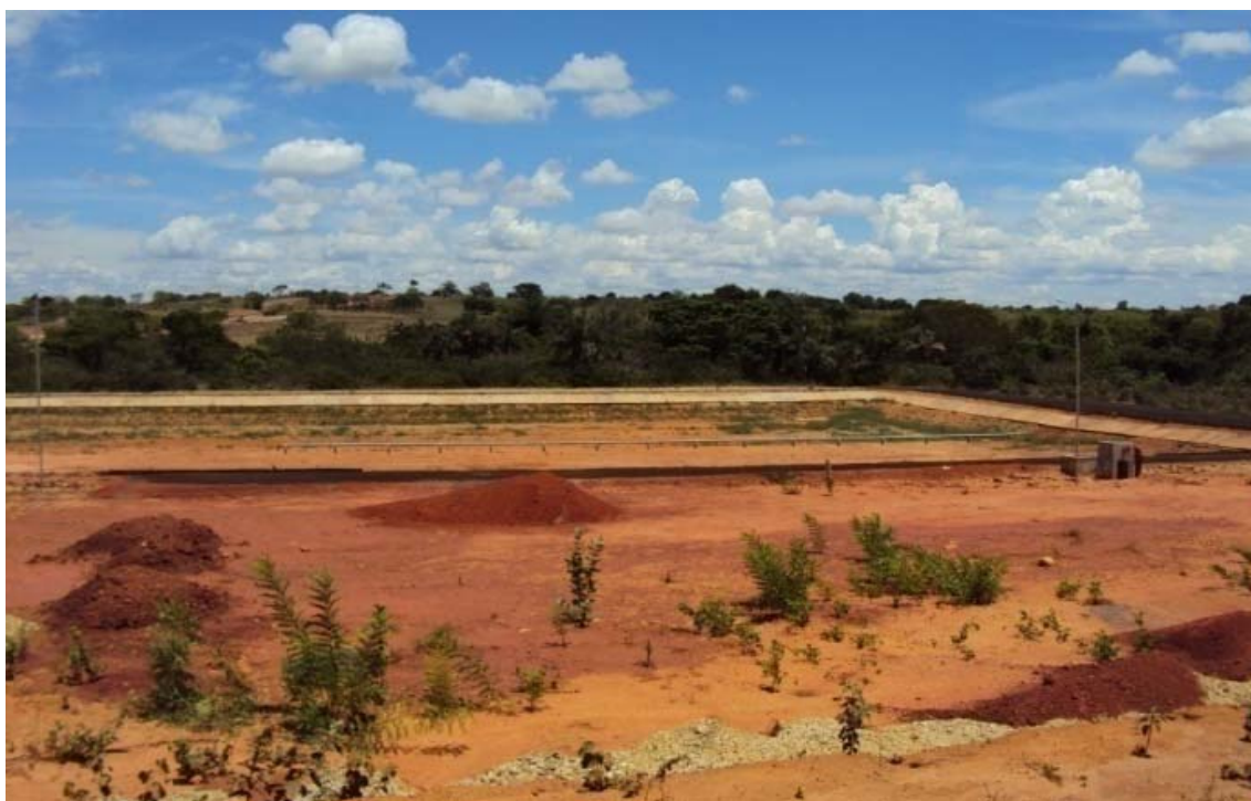
Figura 14.96 - ETE da sede de Montalvânia em fase de construção. Detalhe para a lagoa de estabilização e o rio Cochá ao fundo. Fonte: Ecoplan-Lume-Skill, 2011.
