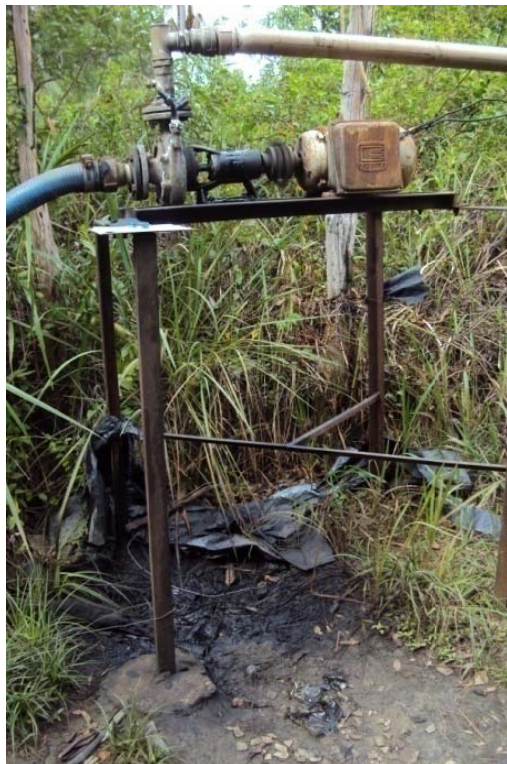
Figura 14.40 -Vazamento da bomba de captação que se encontra próxima ao ribeirão. Fonte: Ecoplan-Lume-Skill, 2011.
