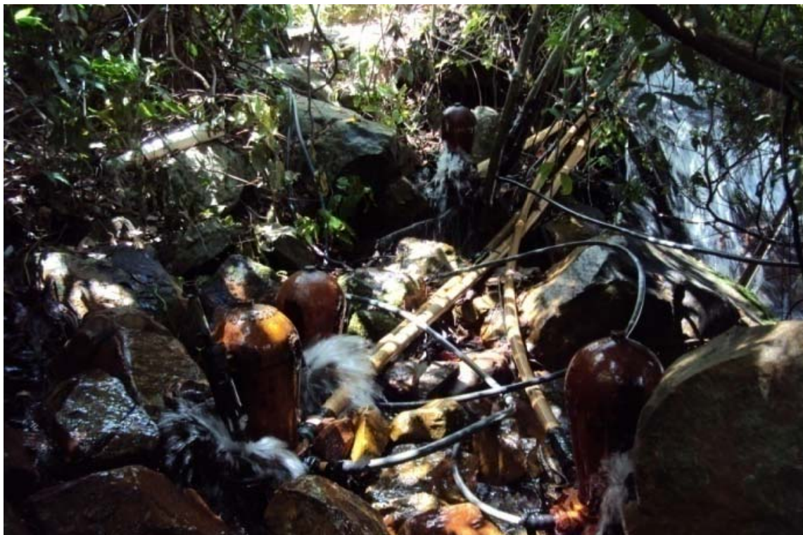
Figura 14.83 - Captações realizadas na margem direita do riacho Gibão para consumo humano, sem tratamento, da localidade de Gibão, em Bonito de Minas. Fonte: Ecoplan-Lume-Skill, 2011.
