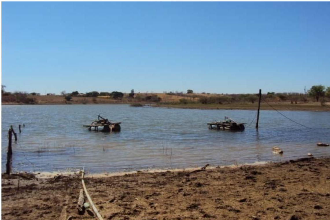
Figura 14.37 -Captações na barragem Santana de São Francisco para a localidade de Água Branca, Olhos D'Água e Cumbucas, todas sem tratamento. Fonte: Ecoplan-Lume-Skill, 2011.
