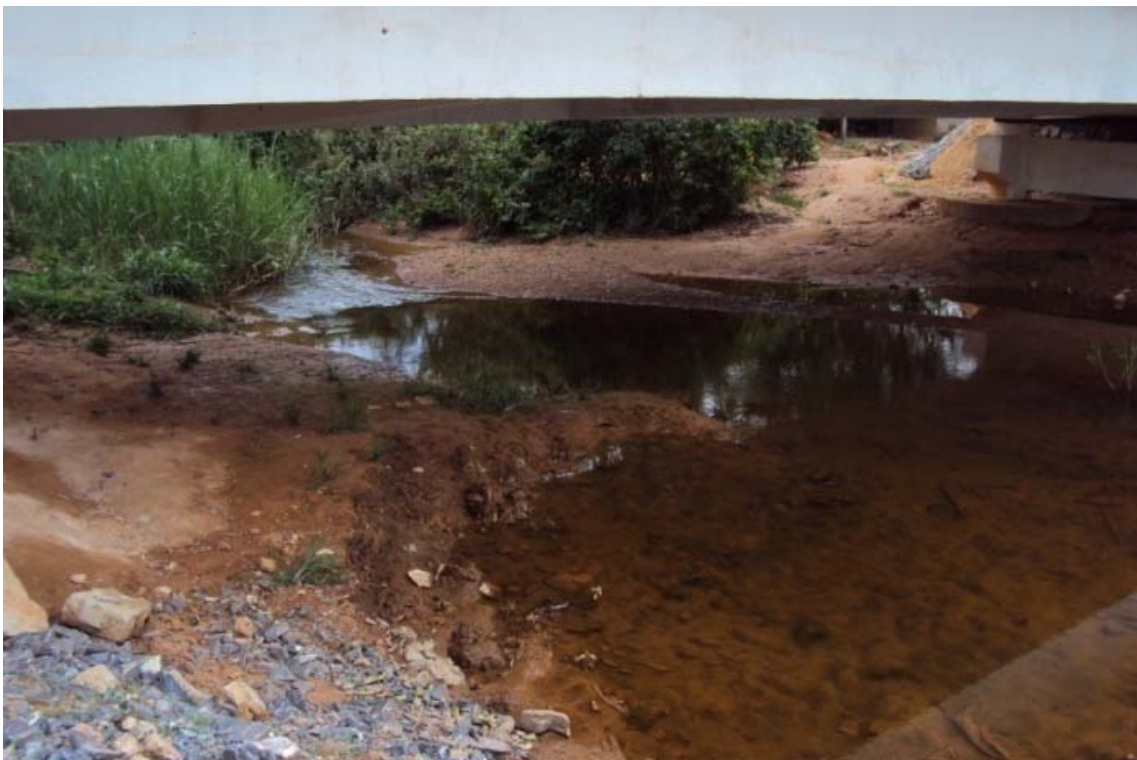
Figura 14.57 -Acúmulo de sedimentos (assoreamento) no riacho da Cruz. Fonte: EcoPLAN-Lume-Skill, 2011.
