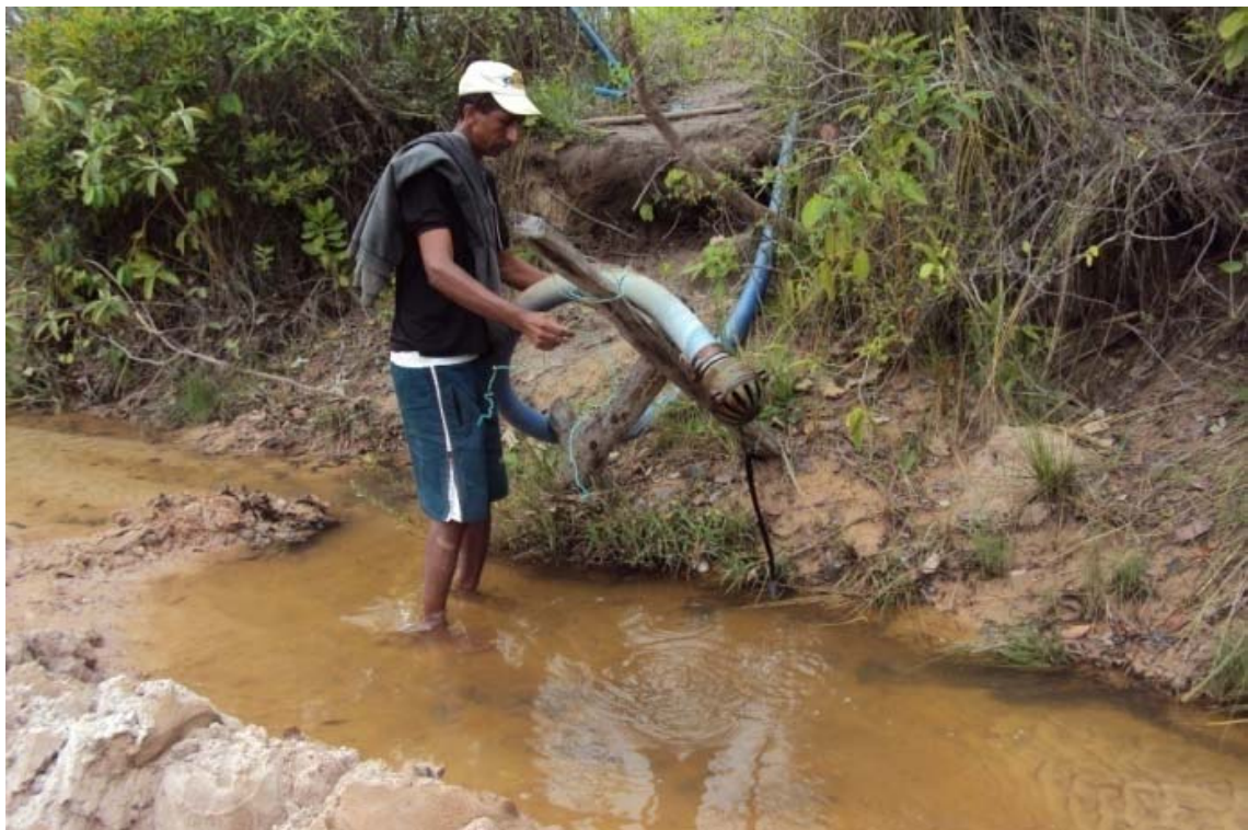
Figura 14.5 -Captação da localidade São Felix no município de Chapada Gaúcha. Fonte: Ecoplan-Lume-Skill, 2011.
