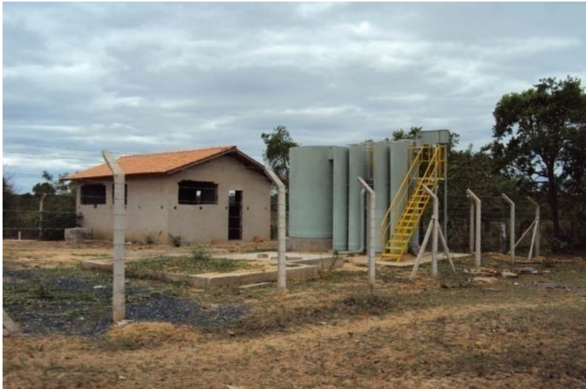
Figura 14.45 -Estação de tratamento de água, com tratamento convencional, em fase de construção na localidade Pandeiros. Fonte: Ecoplan-Lume-Skill, 2011.
