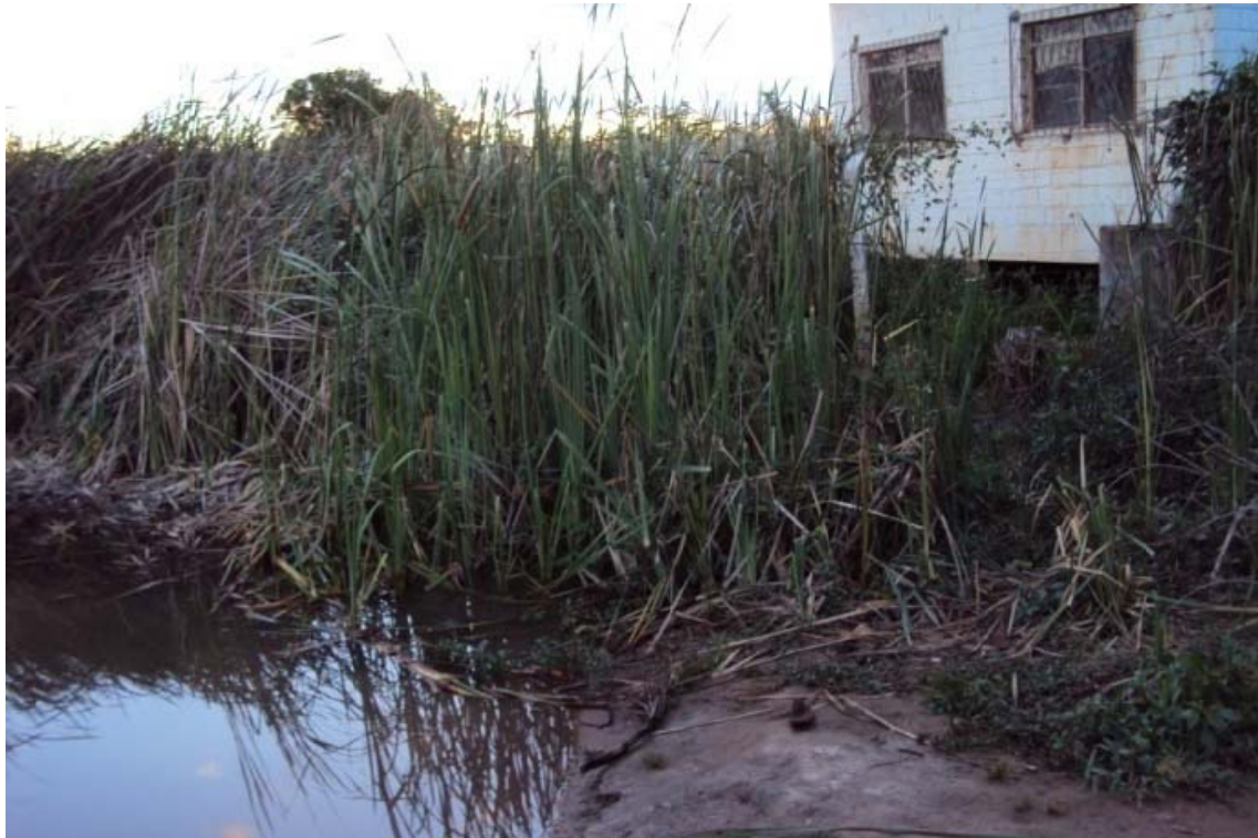
Figura 14.101 - Estrutura da COPASA para captação do distrito de São Sebastião dos Poções. Fonte: Ecoplan-Lume-Skill, 2011.
