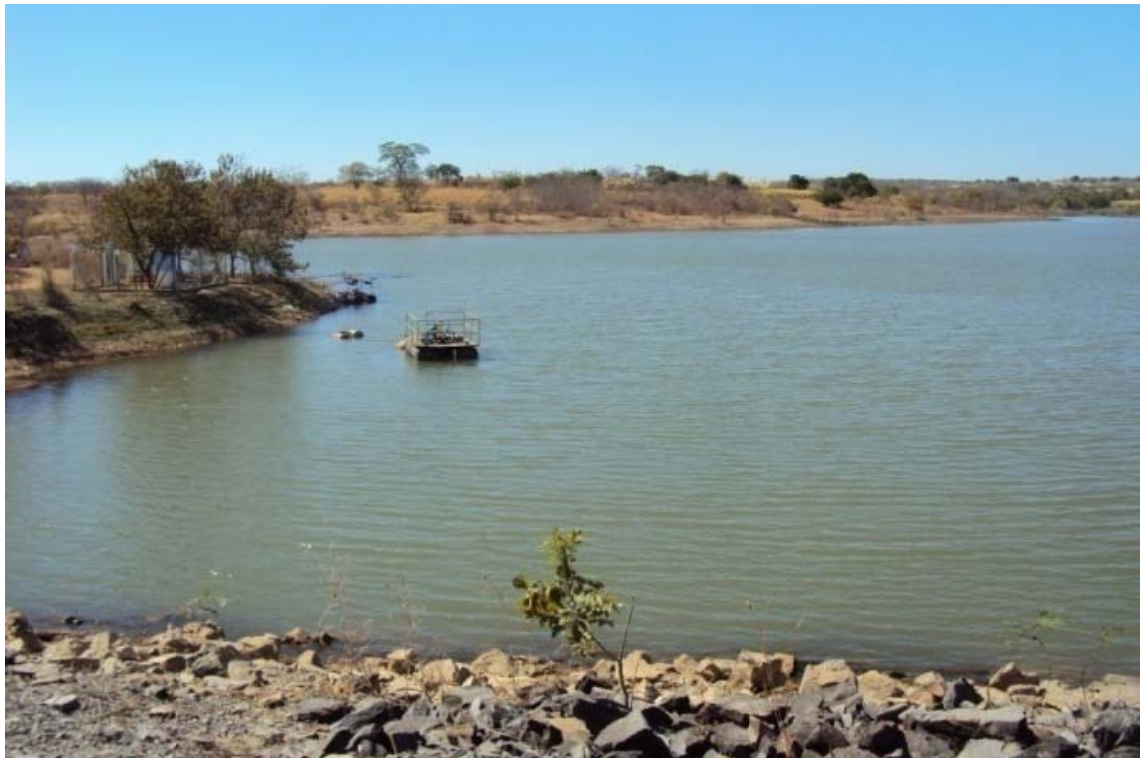
Figura 14.36 -Captação para a localidade Jiboia e Mocambo, ambas na barragem Santana de São Francisco em São Francisco. Fonte: Ecoplan-Lume-Skill, 2011.
