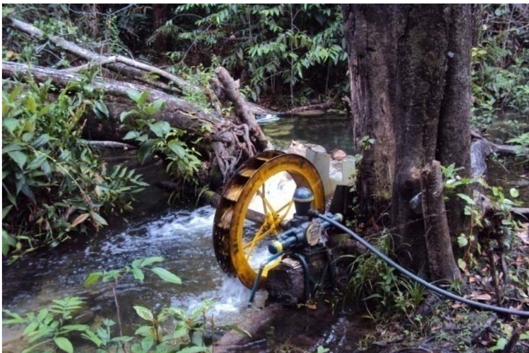
Figura 14.78 - Captação para consumo humano e irrigação de uma pequena propriedade. Fonte: Ecoplan-Lume-Skill, 2011.
