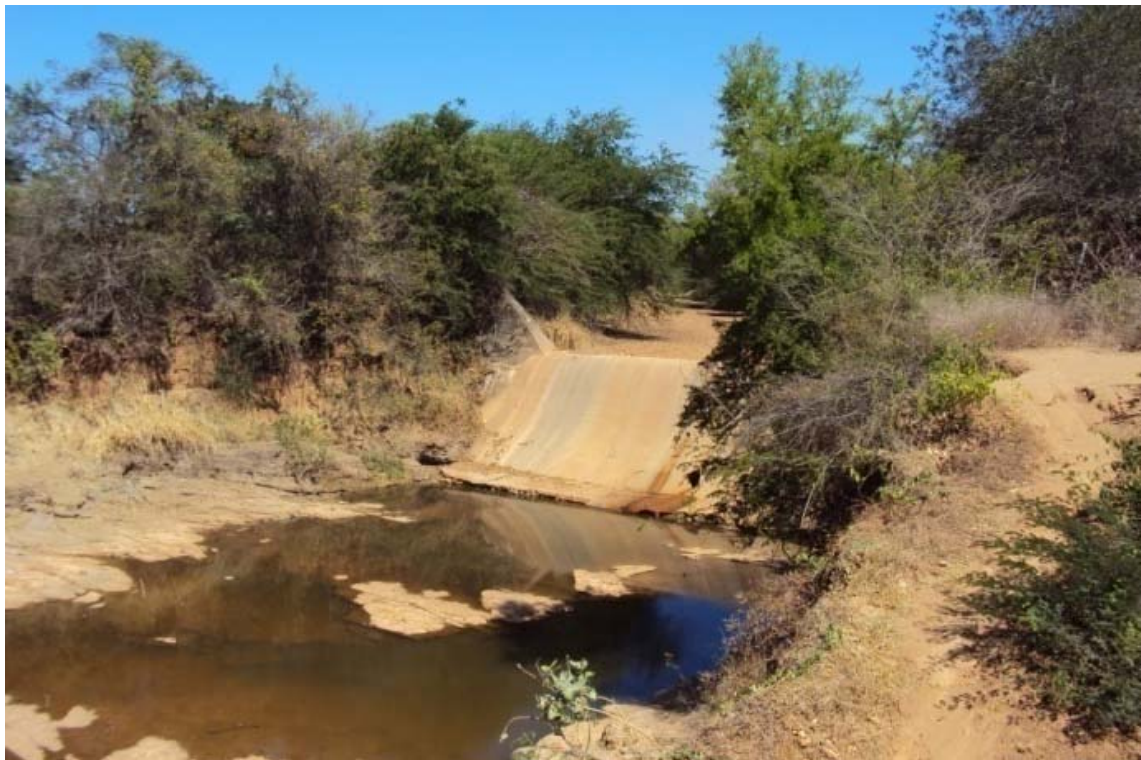
Figura 14.33 -Riacho Buriti do Meio que se encontra seco e assoreado a montante do barramento. Fonte: Ecoplan-Lume-Skill, 2011.
