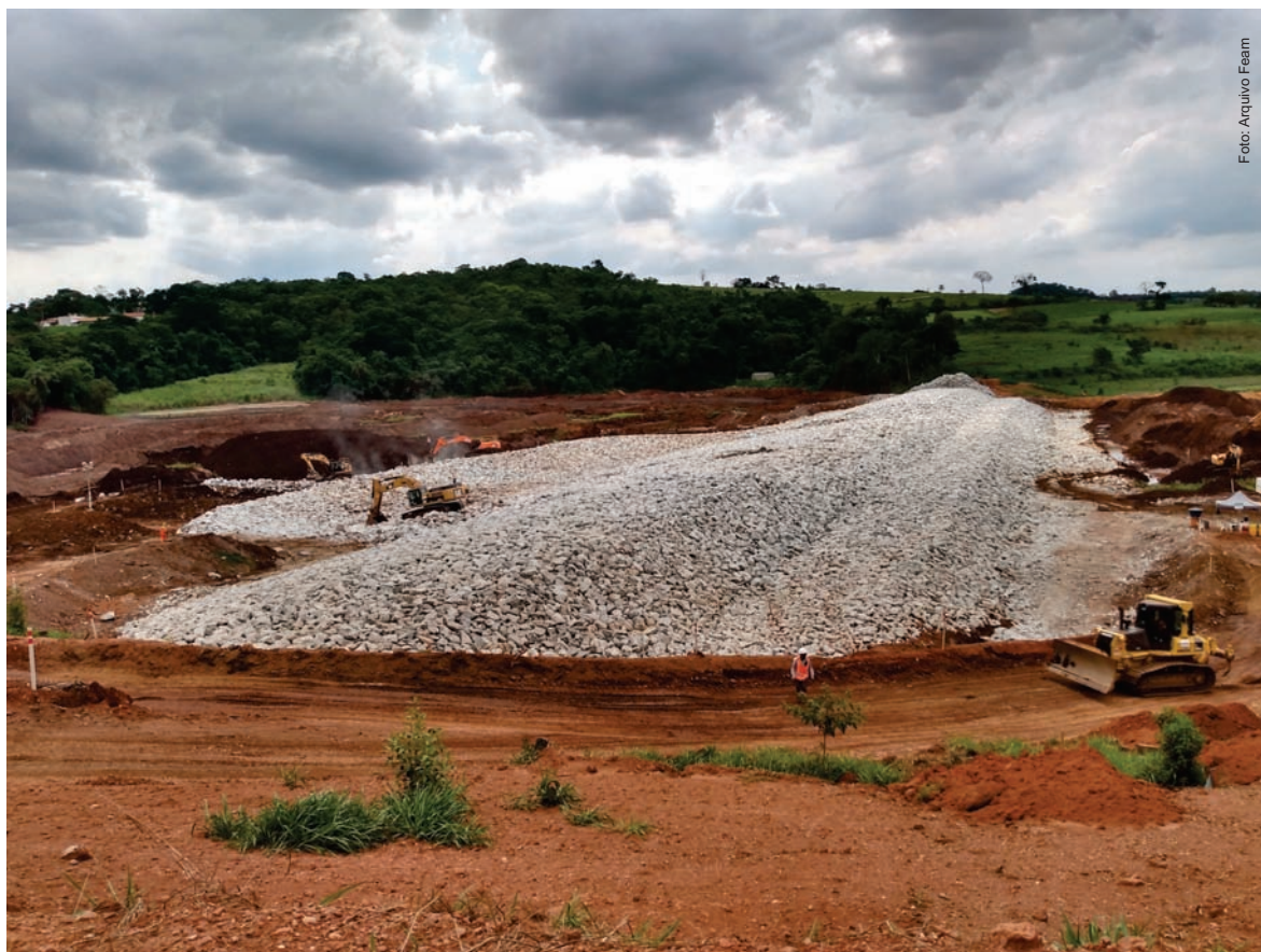
Barreira Hidráulica Filtrante 1 (BH1)
