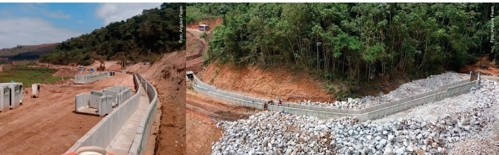
Obras de manutenção e reforço da barragem B-I.
