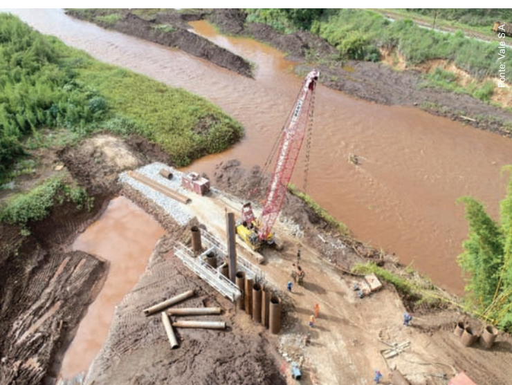
Cravação das estacas para instalação da Cortina metálica 2. Fevereiro de 2019
