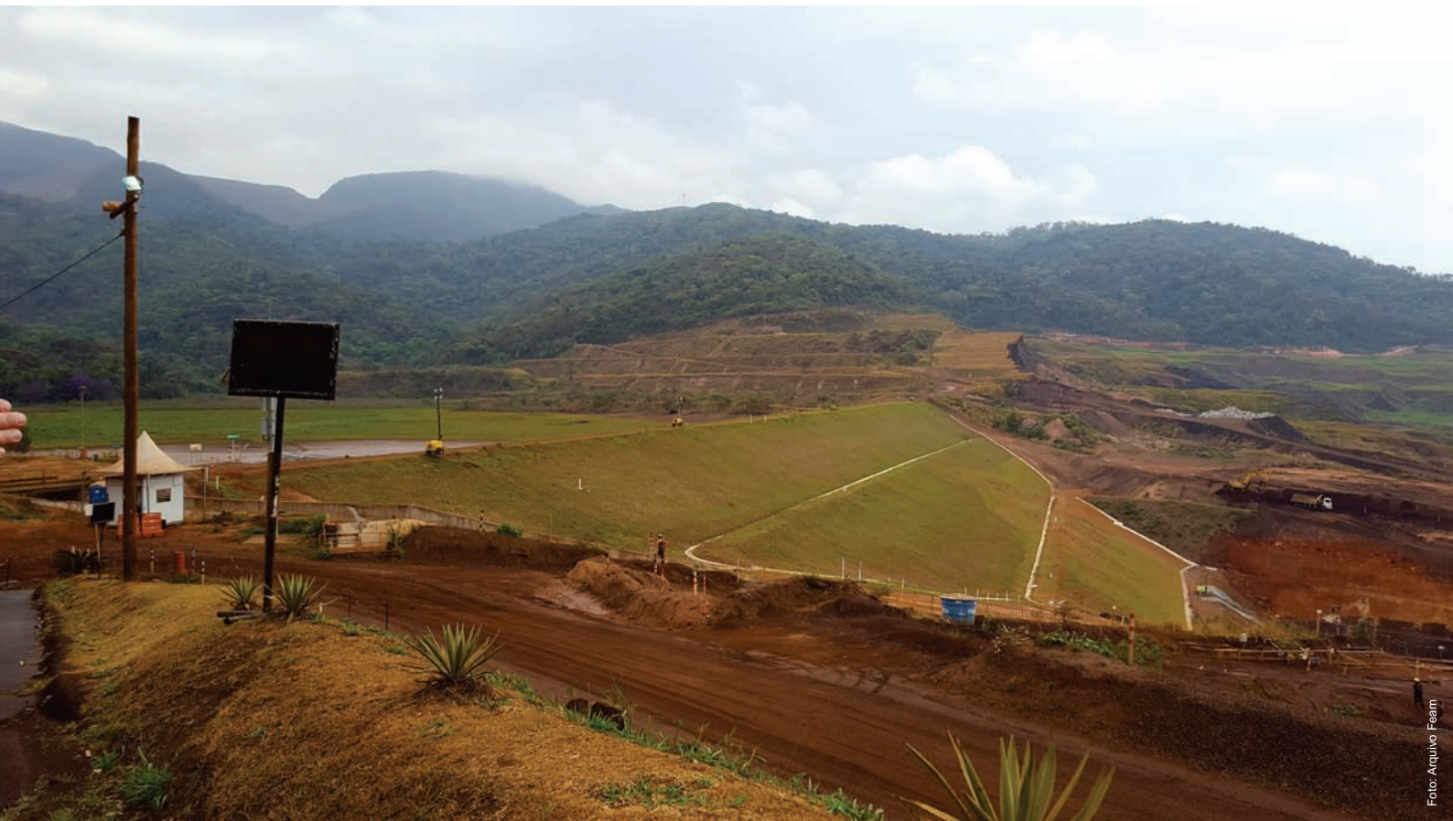
Talude da barragem B-VI
