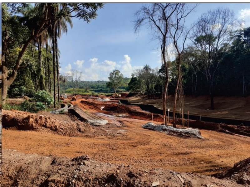
Marco Zero, mostrando a instalação da manta de fibra de coco, para fins de proteção do solo. 25 e 26 de novembro de 2019
