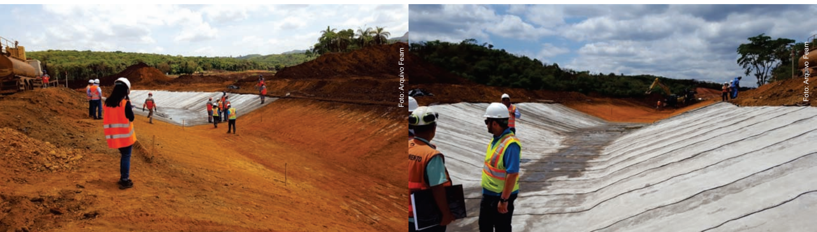
Instalação de Concreto Canvas
