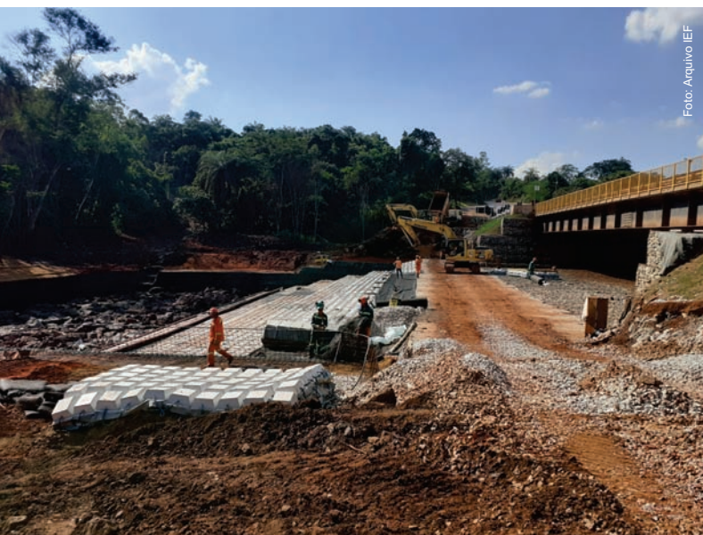
Marco Zero, com instalação de estrutura de revestimento do canal em blocos de concreto articulados. 25 e 26 de novembro de 2019
