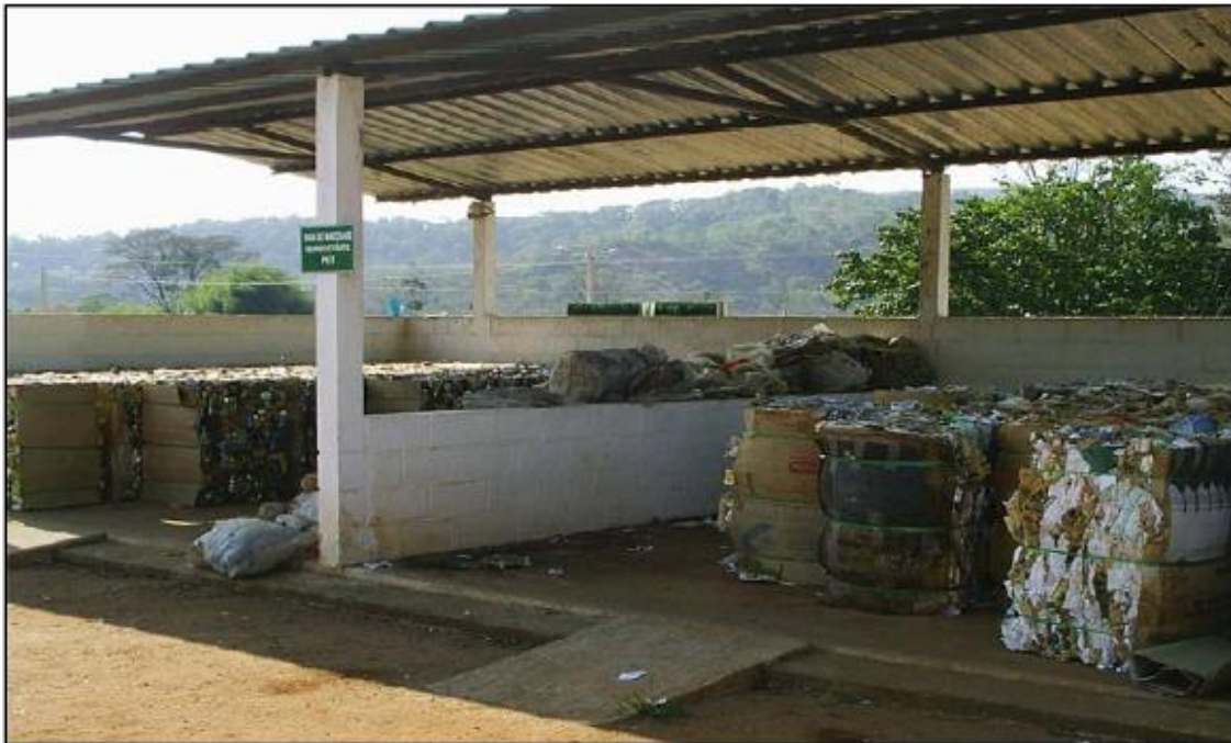
Figura 3.9 – Unidade de triagem e compostagem – Processamento de recicláveis.
